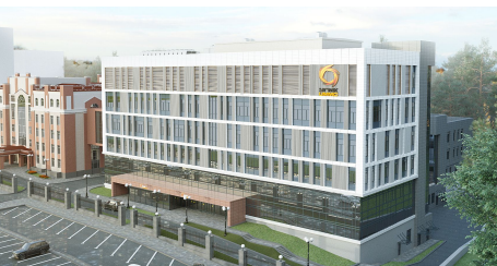
Автоматизация палат и инженерных систем здания Медцентр УГМК-ЗДОРОВЬЕ, г. Екатеринбург
