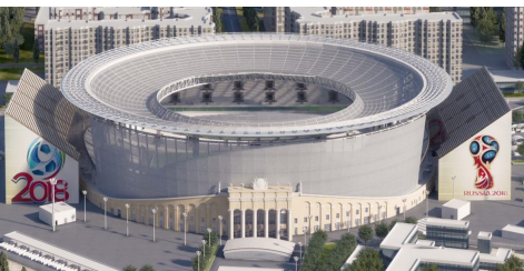
Управление освещением и безопасностью Стадион Екатеринбург Арена, г. Екатеринбург
